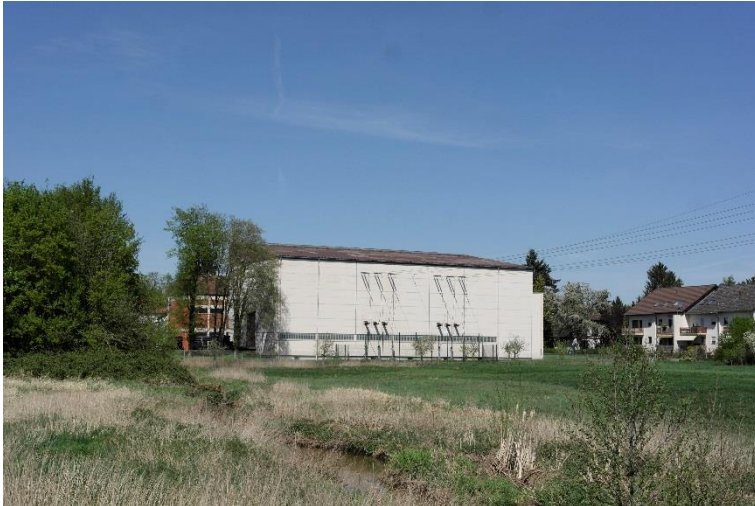
Abbildung 67: Bieber-Aue – Umspannwerk (Eigene Aufnahme)
