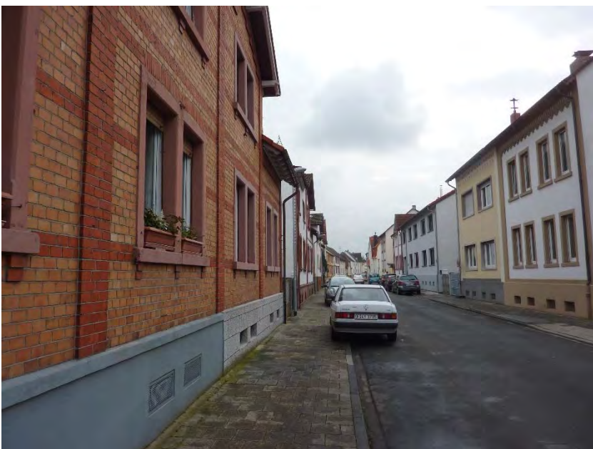
Beispiel eines geschlossenen Straßenraumes mit traufständiger Bebauung: Feldstraße
