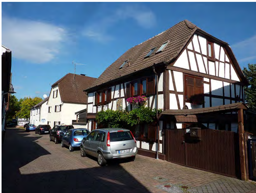
Beispiel eines Fachwerk-Wohnhauses mit Sichtfachwerk (Kirchstraße 12)
