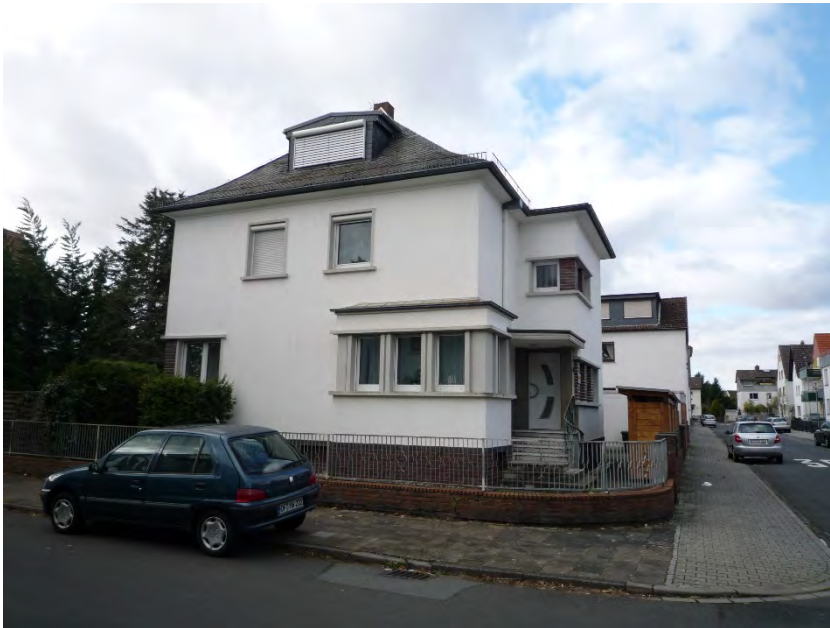
Beispiel des Gebäudetyps eines Wohnhauses der 1920er Jahre (Schönbornstraße 18)
