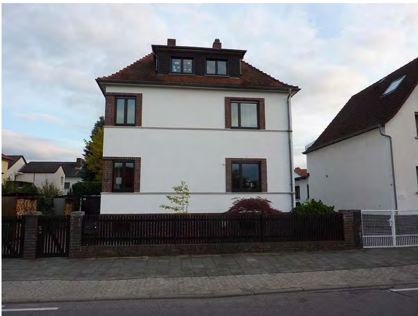
Beispiel für Gestaltkategorie 2: Gebäude mit hohen Gestaltqualitäten der Nachgründerzeit (Hohebergstraße 22)
