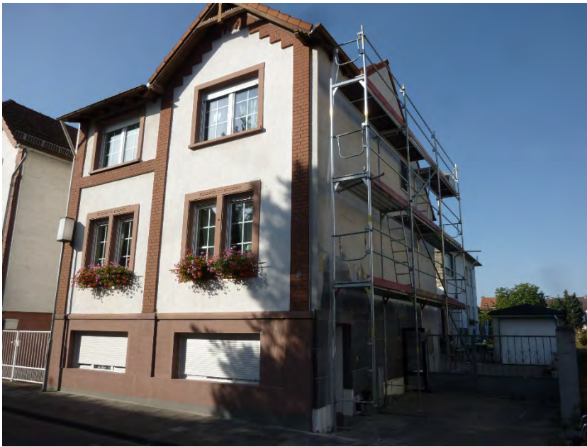
Beispiel für Gestaltkategorie 2: Gebäude mit hohen Gestaltqualitäten der Gründerzeit (Bürgermeister-Kämmerer-Straße 19)
