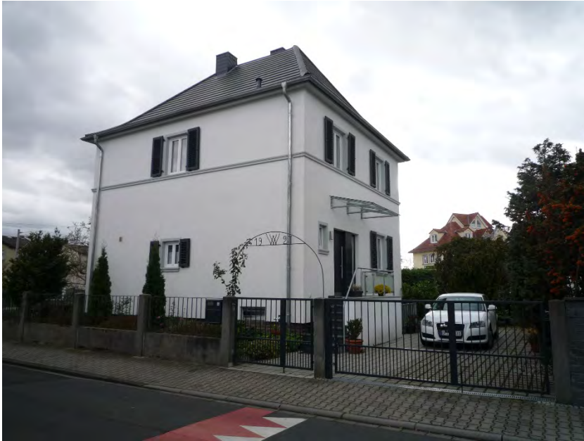
Beispiel des Gebäudetyps eines Wohnhauses der 1920er Jahre (Schönbornstraße 12)
