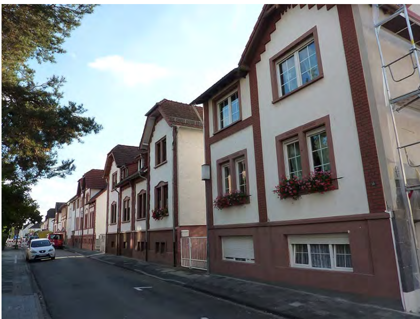
Beispiel eines besonders hochwertigen gründerzeitlichen Gebäude-Ensemble (Kategorie 1): Bürgermeister-Kämmerer-Straße 13 bis 29
