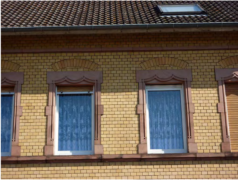
Beispiel einer gründerzeitlichen Backstein-Fassade – Fensterdetail (Forststraße 4)
