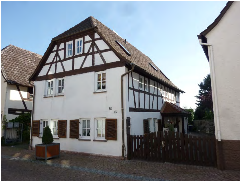
Beispiel des Gebäudetyps eines giebelständigen Wohnhauses einer Hofanlage im dörflichen Ortskern (Schloßstraße 33)
