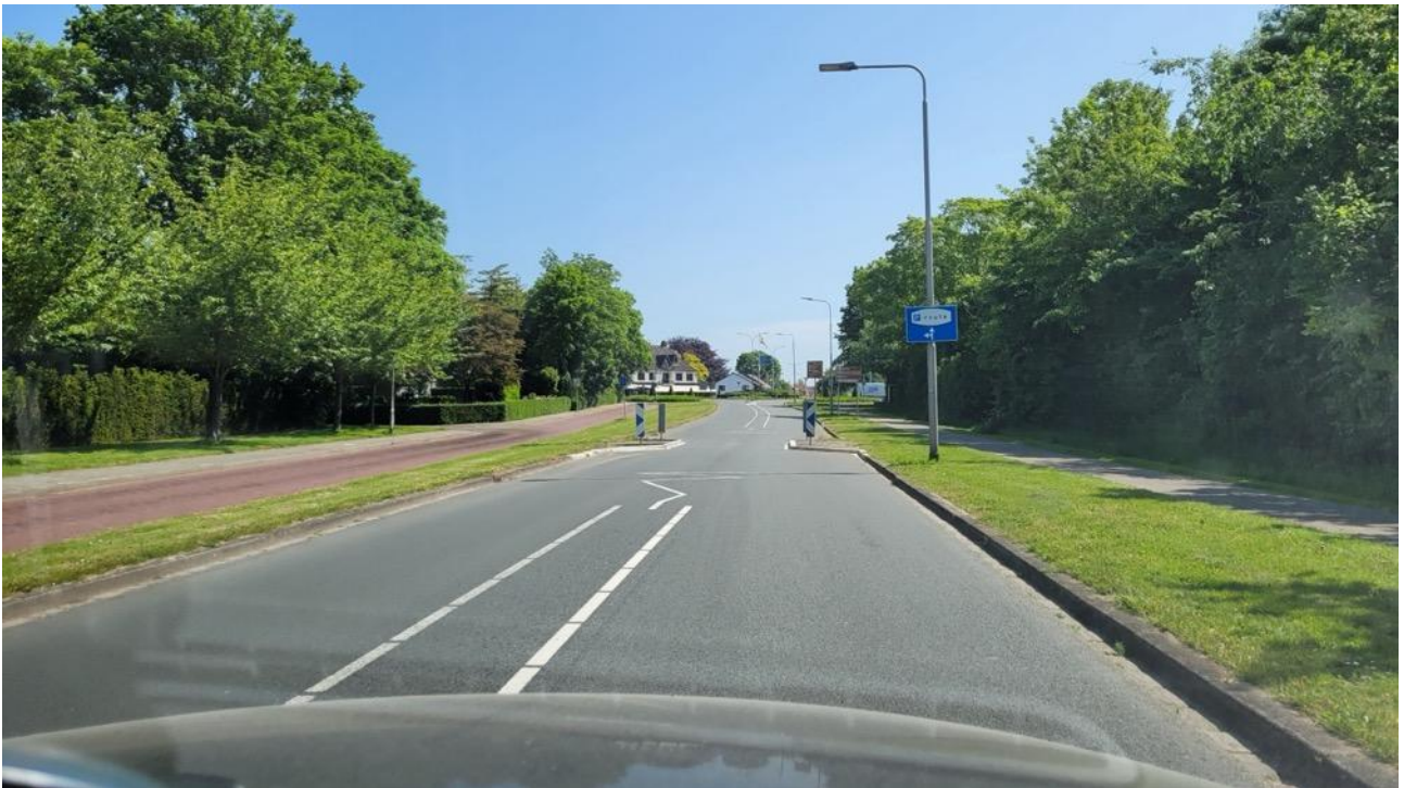
Ortschaft Axel in den Niederlanden: Verengung der Autofahrspuren auf einen einspurigen Durchlass, um Geschwindigkeit und Verkehrsmenge zu reduzieren. Eine Idee für die Frankfurter Straße in Heusenstamm?
