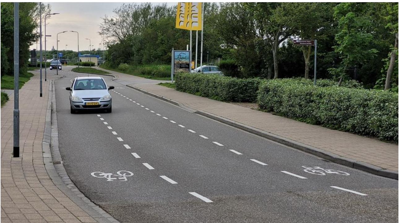
Viel befahrene Straße in Zoutelande (Niederlande) mit enger Kernfahrbahn . Funktioniert bestens.
