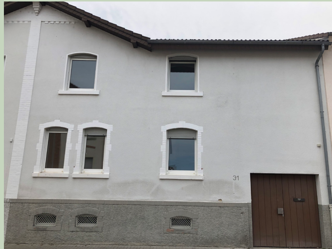
Außenfassade Paulstraße 31, vorher
