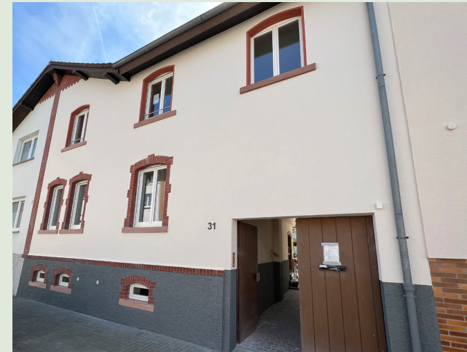
Außenfassade Paulstraße 31, nachher
