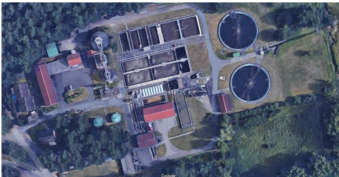
Abbildung 9: Luftbild Kläranlage Heusenstamm
