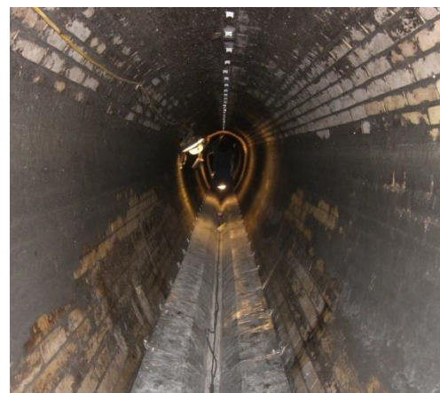
Abbildung 13: Wärmetauscher in Abwasserkanal
