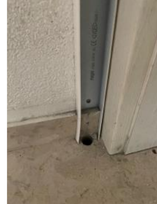
Mittels Brandschutzkabelkanal errichteter Treppenhaus Steiger
